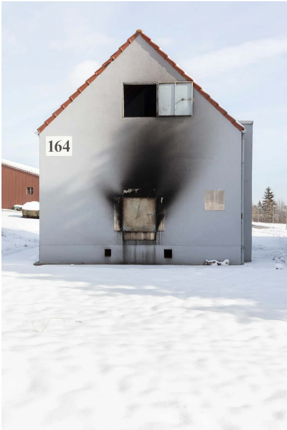
Aufnahme eines Brandübungshauses.
