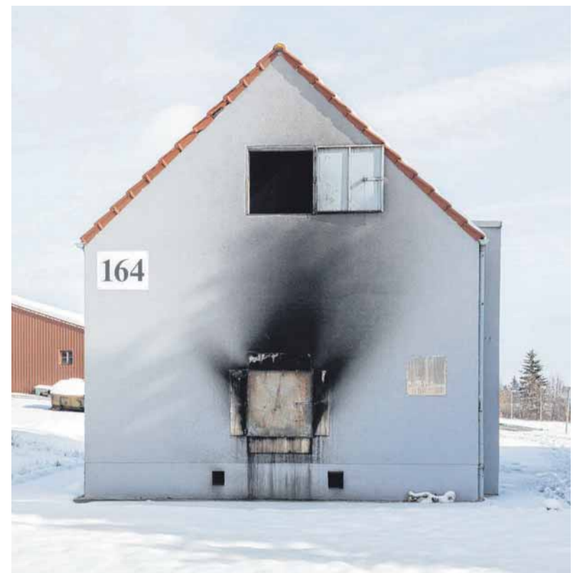
Eine Brandübungsanlage der Schule für ABC-Abwehr auf dem Truppenübungsplatz in Stetten am kalten Markt.
