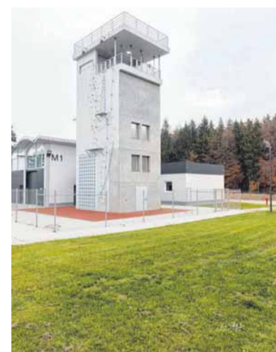
Auf dem Dach des Kletterturms in Pfullendorf werden Soldaten aus Hubschraubern auf- und abgeseilt.
